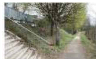
Les débris divers atterrissent souvent dans le canal.
